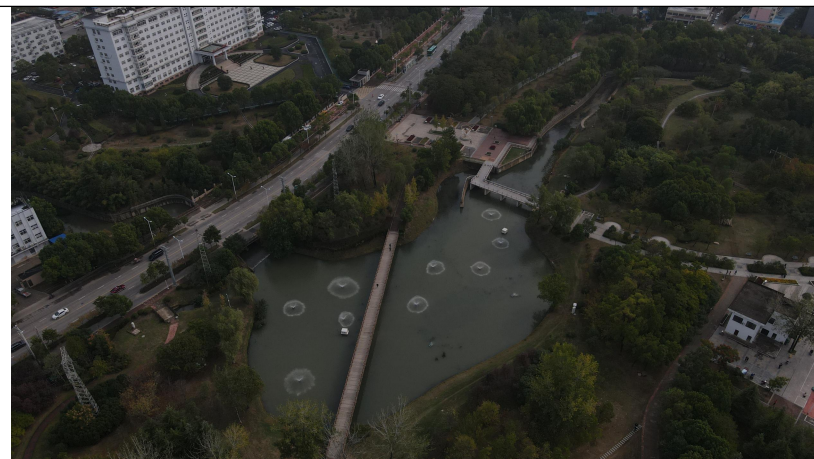
蒋家沟曝气池
