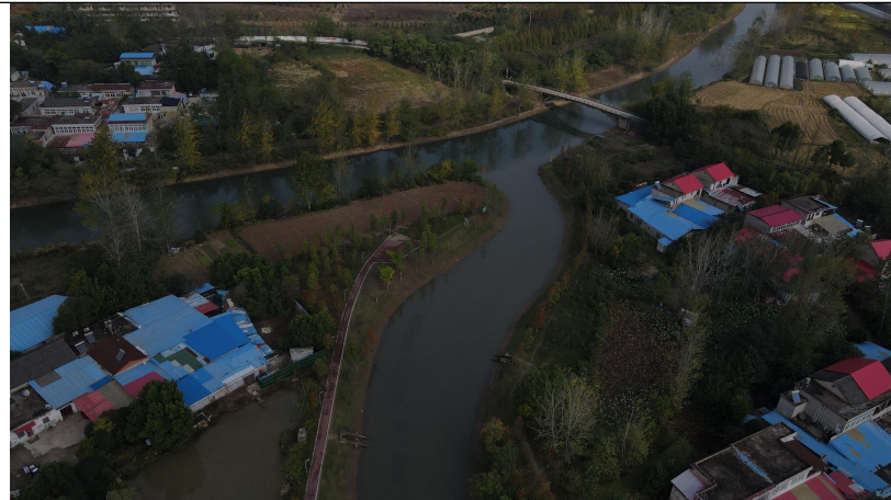
安丰明渠现状
