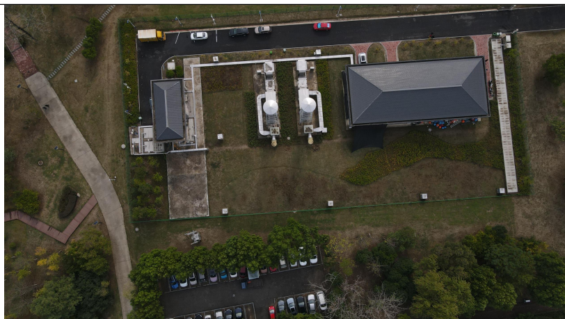
蒋家沟调蓄池
