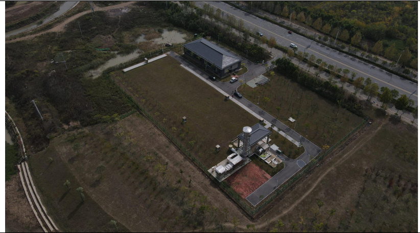
小高堰调蓄池
