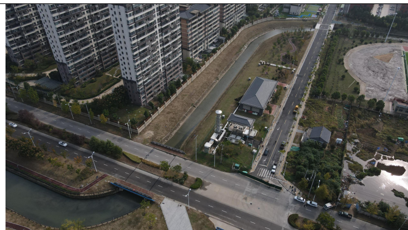
蒋家沟调蓄池
