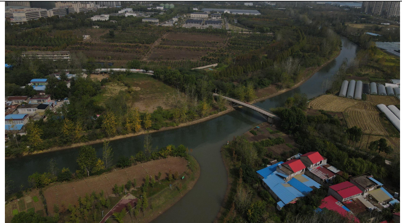
安丰明渠现状
